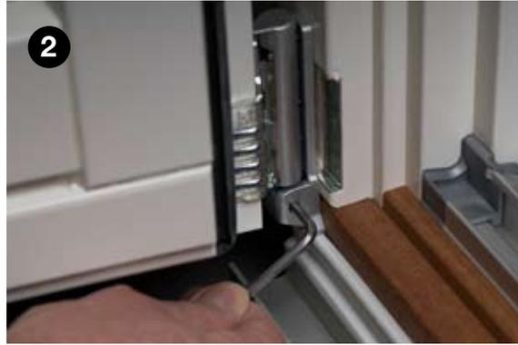
1. Oberstes Scharnier: Nehmen Sie einen 4 mm-Innensechskantschlüssel für die Schraube, die ganz oben auf dem Scharnier (mit Öffnung zum Rahmen) sitzt.
