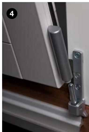
1. Kunststoffabdeckung vom oberen Scharnier lösen
