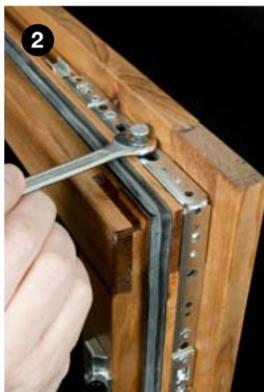
1. Mittels 4 mm-Innensechskantschlüssel den Zapfen im Uhrzeigersinn (nach rechts) drehen, um die Tür näher an den Rahmen zu spannen.
